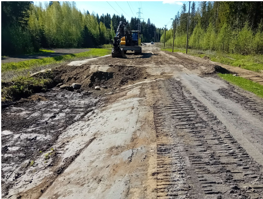
Kuva: Kalevankankaan tykkilumenladun pohjat työn alla
