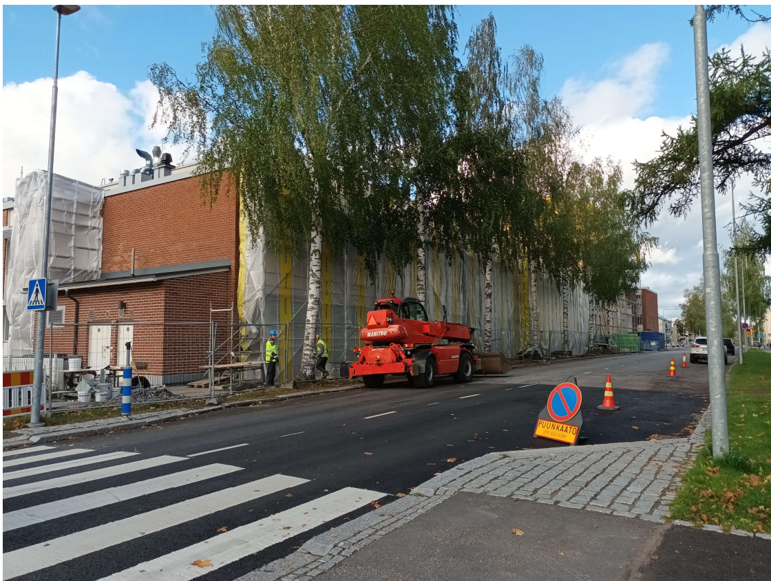
Kuva: Päämajakoulun julkisivu- ja vesikattokorjauksen työmaa
