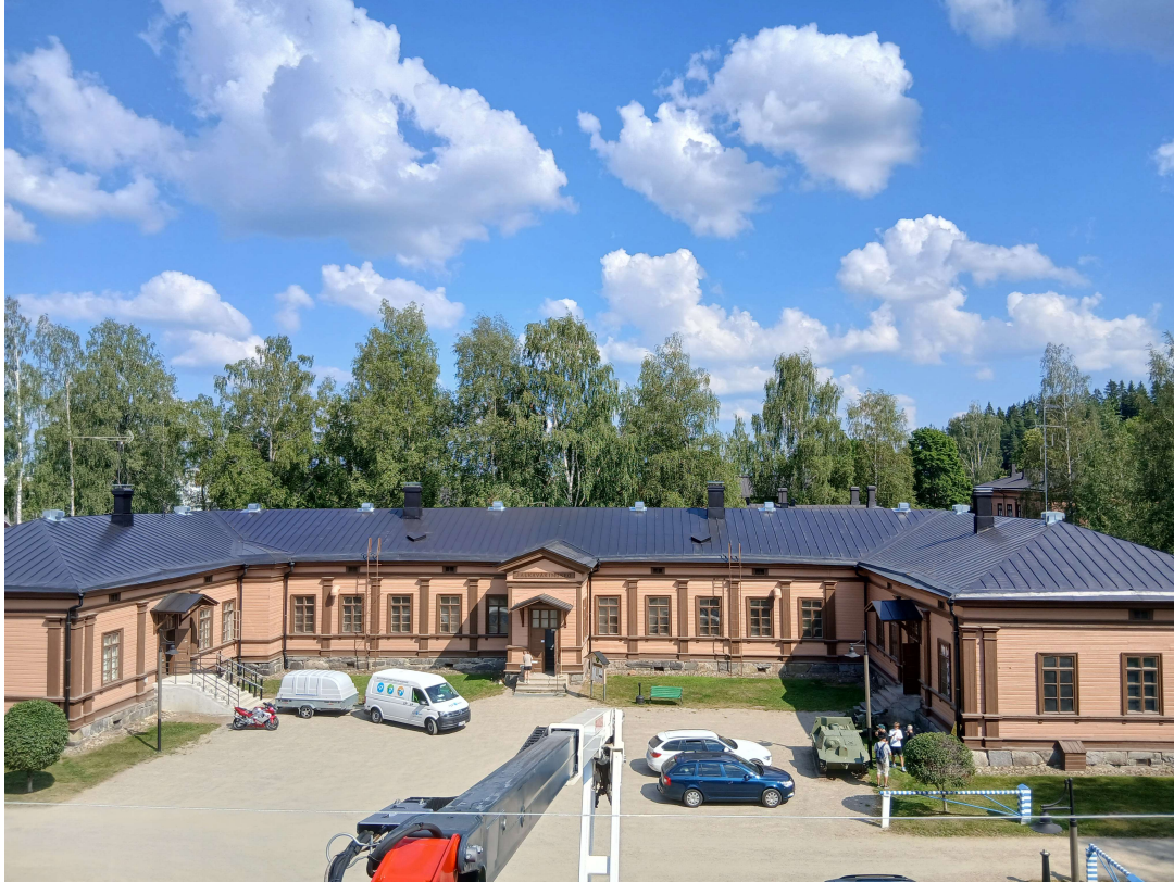
Valokuva Jalkaväkimuseon kunnostettu vesikatto
